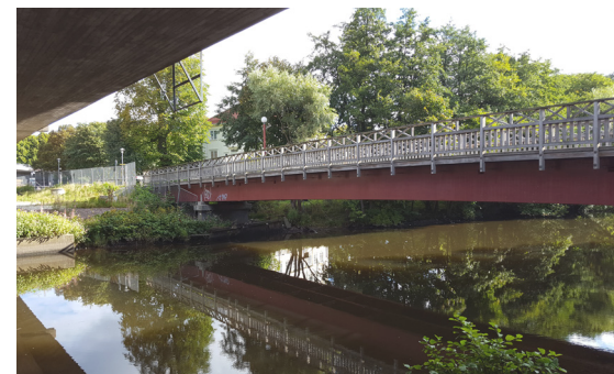
BEFINTLIG GÅNG- OCH CYKELBRO VID ÅPARKEN
