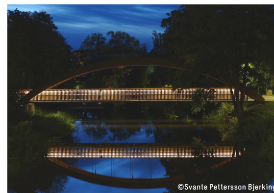
EXEMPEL LJUS I HANDELDARE PÅ TRÄBRO, VY FRÅN SIDAN, FYRISSPÅNGEN FYRISSEKOLAN UPPSALA.
