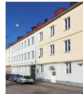
LANDSHÖVDINGEHUS VID GAMLESTADSVÄGEN
