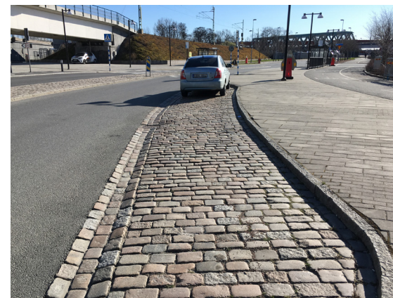
MARKBELÄGGNING AV LJUS BETONGMARKSTEN PÅ GÅNGYTA OCH STORGATSTEN PÅ PARKERINGSPLATS, GAMLESTADS TORG ETAPP 1.
