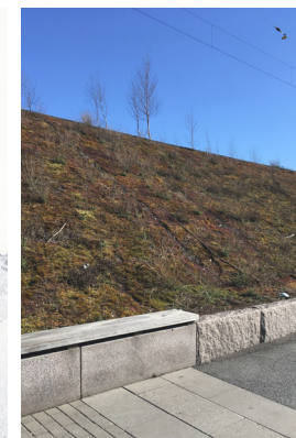
BEFINTLIG JÄRNVÄGSBANK LÄNGS WATERLOOGATAN
