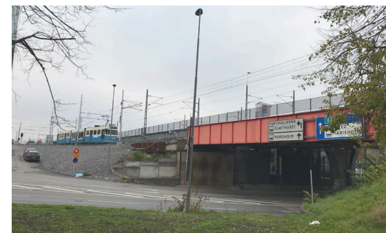
BEFINTLIG SLAKTHUSBRÖ MOT RESECENTRUM
